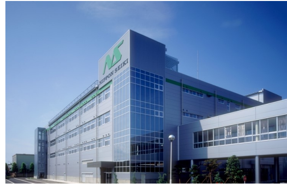
日本精機 NS テクニカルセンター
