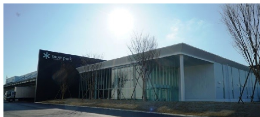
スノーピークオペレーションコアHQ 2
